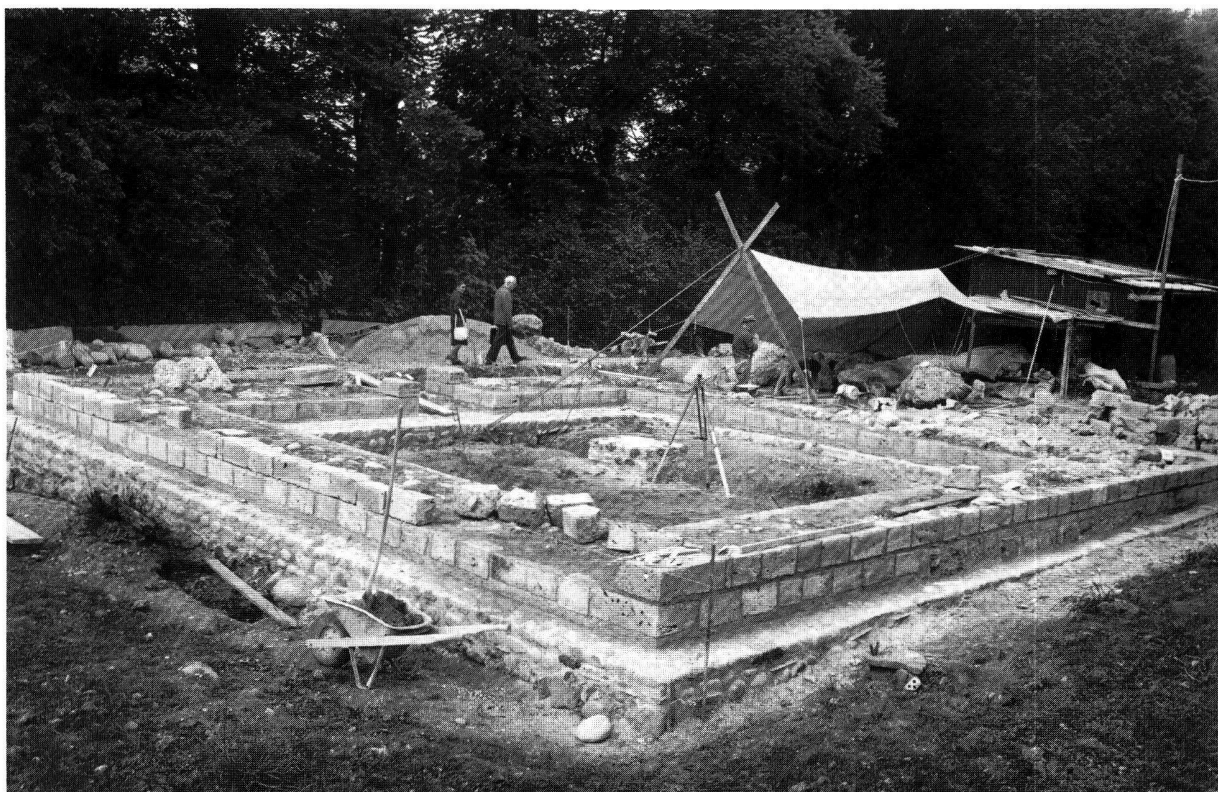
Abb. 6. Die Turmuine während der Rekonstruktion der Tuffsteinquader-Verblendung. Von Südwesten.
