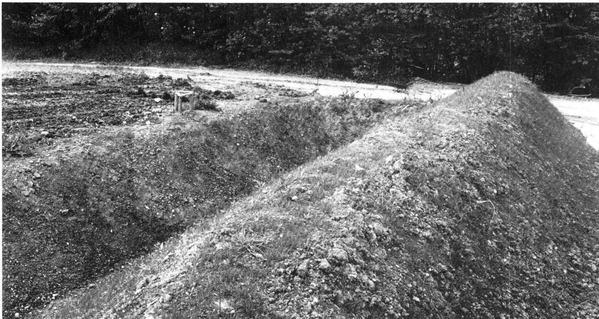
Abb. 14. Der nördliche Teil des ausgehobenen Westgrabens (links) und der mit dessen Aushub wieder rekonstruierte Wall (rechts). Von Südosten.
