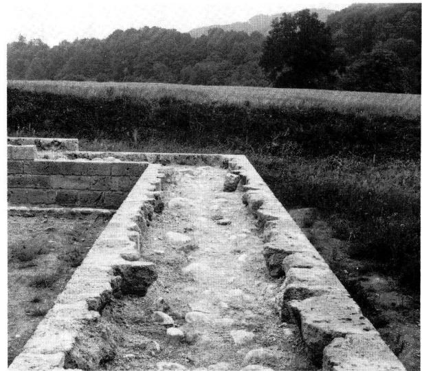
Abb. 10. Die Westmauer nach Erstellung der Tuffsteinquaderverblendung bzw. vor dem Einbau der Geröllabdeckung. Von Norden.
