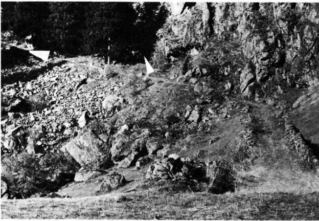
Abb. 17. Alter Tal- und Passweg oberhalb Pozzol in Richtung La Rōsa hinauf gegen Sasseggl. Die ältere Wegvariante führte vor der ersten Tanne, den Fels meidend, sehr steil hinauf. Vorne in der Wiese ist der Weg beidseits von Mauern begleitet. Ganz vorne wurden sie durch den letzten Fahrwegbau zerstört.
