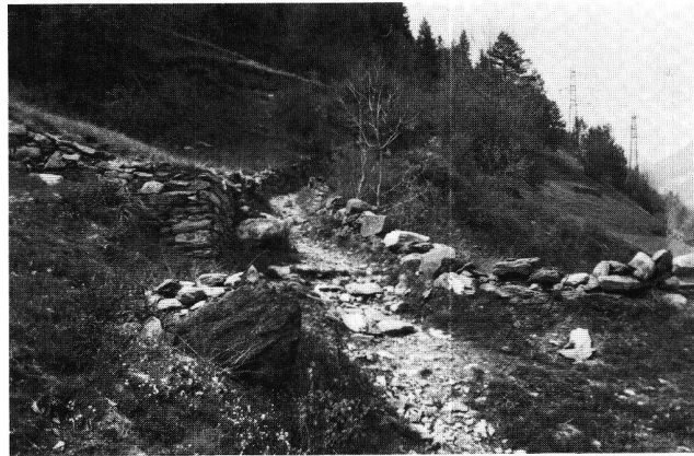
Abb. 1a. 1 km nördlich von Poschiavo verlässt der einstige Lokal- und Passweg die Allmend auf der Nordseite des Varunasch (Baches). Er mündet wie überall im Puschlav von zwei Mauern flankiert in die Zone des Privatbesitzes, hier in die einstigen Äcker (801 150/135 200). Blick gegen Norden.
