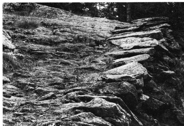
Abb. 5. Pflasterung und Stützmauer des eindrucklichen Weges zwischen Prairolasc und Cavaglia.
