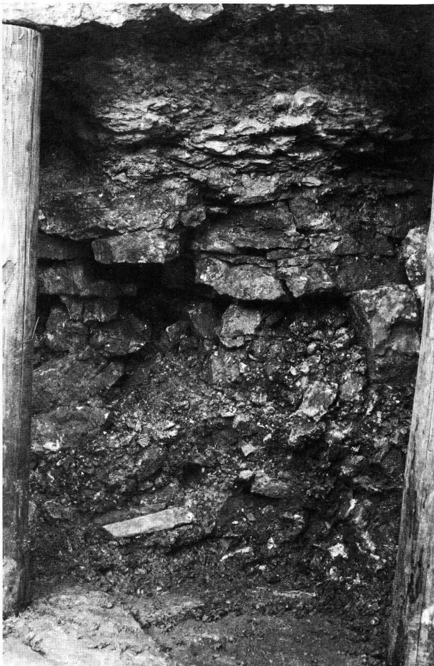
Abb. 11. Pleigne JU, Löwenburg. Zentralplatz, Ausweitung West: Teil des Untertagebaus («Weitung») mit der heutigen Sicherung durch Holzstempel. Der Bergbauschutt in der unteren Hälfte gibt die Höhe des alten Abbaus an.
