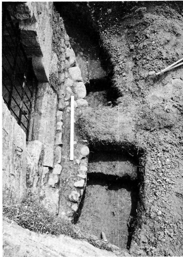
Abb. 50. Stein a.Rhein SH. Spätromisches Kastell auf Burg. Blick von der südlichen Kastellmauer auf das runde Fundament des Südostturmes. Auf diesem Fundament Reste der einen Seitenfläche des im Plan auf einem regelmässigen Siebeneck basierenden Turmes. Die Mauerverblendung oberhalb der Tuffsteinschwelle der Ausfallpforte ist seit 1900 mehrfach überarbeitet worden.
