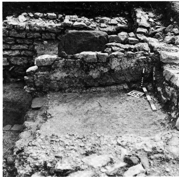
Abb. 42. Augst BL, Steinler. Insula 36. Wohntrakt des Hauses B. Raum mit Bodenheizung, Ostecke. Terrazzoboden mit Viertelrundstab am Übergang zur verputzten, bemalten Wand. Ansicht von Westen.
