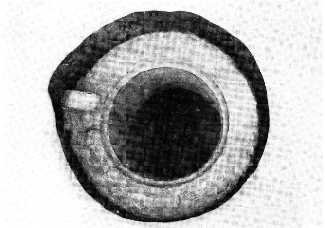
Fig. 55. Martigny VS. Thermes du téménos. L'embouchure en plomb de l'écoulement du bassin froid S. Diamètre extérieur 9,5 cm.
