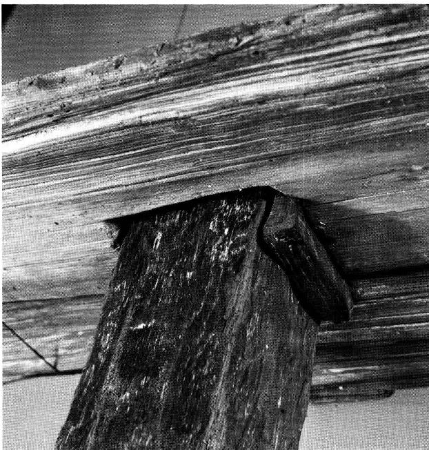
Abb. 4. a: Querschnitt durch Fleckling 516 mit Pfehl 575. b: Längsschnitt durch Fleckling 366 mit Pfehl 367 und von unten eingeschlagenem Keil 980. c: Studioaufnahme derselben Konstruktion: Detailsicht von unten her gesehen.
