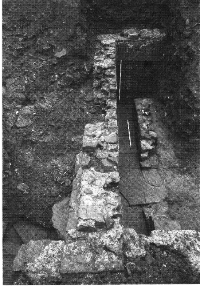
Fig. 6. Montreux-Baugy VD 1987. Annexe orientale. Vue de la canalisation aménagée dans les soubassements d'un avant-corps.
