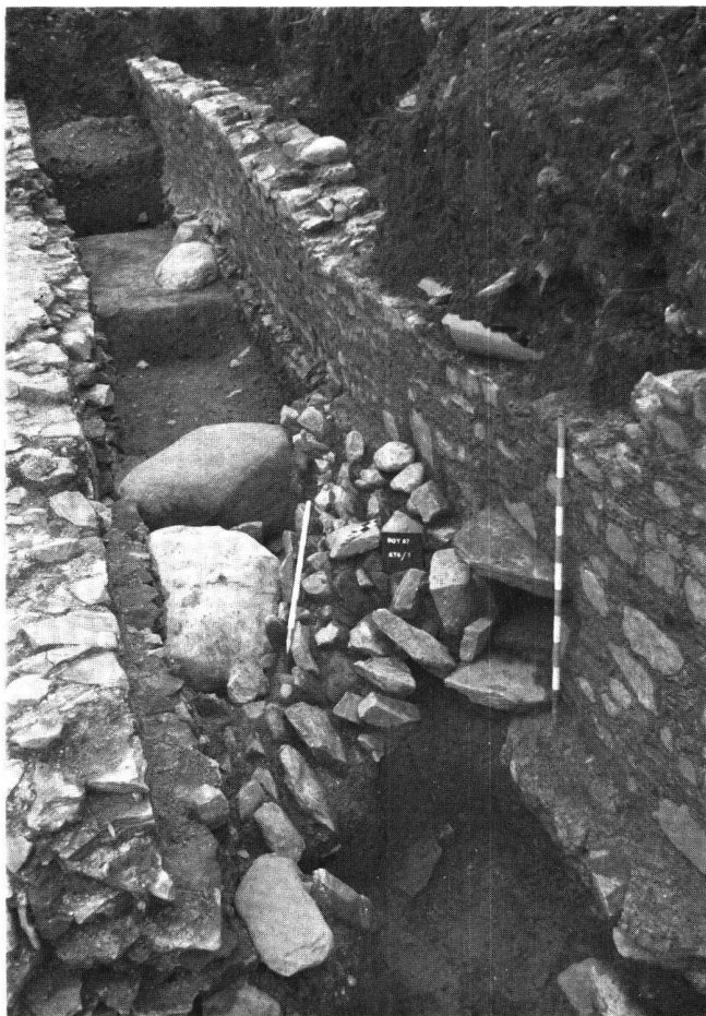
Fig. 7. Montreux-Baugy VD 1987. Vue de la barbacane percée dans le mur de terrasse pour le passage d'un drain. A gauche de ce conduit, les restes d'un pan du mur de terrasse effondré.
