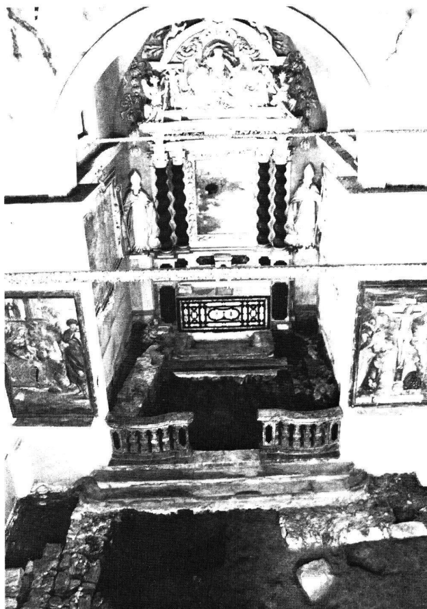
Fig. 12. Bioggio, Oratorio di San Ilario. Veduta generale dell'area esplorata prima dell'esame dell'altare. Nell'area presbiteriale si notano i muri della chiesa carolingia mentre nella navata (a destra) sono in evidenza i due muri esterni.
