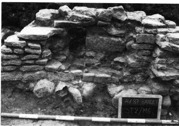
Fig. 6. Avenches VD, Derrière la Tour (1987). Vue du mur nord du bassin, détail d'une ouverture aménagée pour l'écoulement de l'eau. A noter également le parement interne constitué de fragments de tegulae. Deuxième moitié 1er siècle apr. J.-C.
