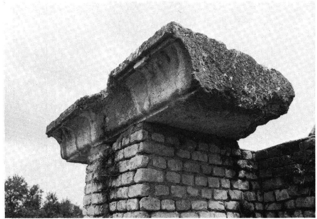
Fig. 4. Corniche à goutte pendante (longueur 2.28 m, largeur 1.20 m, hauteur 0.38 m), trouvée en 1909 et scellée sur un contrefort restauré du mur de l' ambitus (photo JBG).
