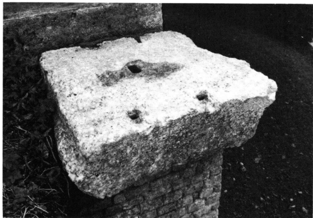
Fig. 5. Corniche de même profil (longueur 1.14 m), avec son trou de louve et ses quatre trous de scellement (photo JBG).
