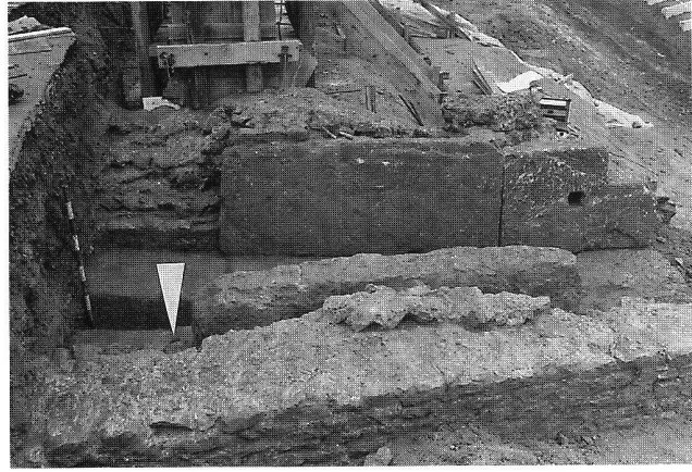
Fig. 12. Avenches VD, Amphithéâtre. Vomitoire IX vu des deux côtés. Vestiges des murs latéraux. Fondations et revêtement des faces visibles et à l'air libre en grand appareil des grès de la Molière. Noter (flèche) la crapaudine de la grille qui fermait le passage voûté, bâti en grand appareil, à son débouché dans la cavea .
