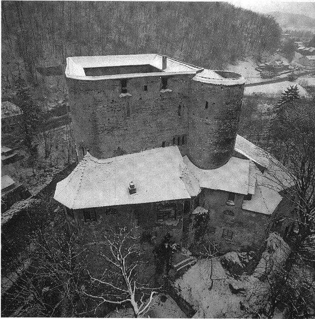
Abb. 23. Duggingen BE, Ruine Angenstein. Burganlage von Osten.
