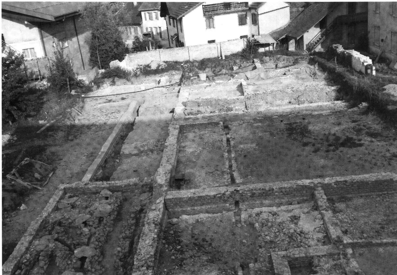
Fig. 30. Yvonand VD, Mordagne. Vue générale des fouilles. A gauche, le stylobate du péristyle à l'endroit où il est conservé et – en bas – le système d'hypocauste appartenant au réaménagement tardif du site.
