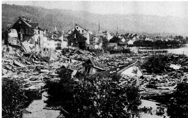
Abb. 2. Zug, Die Zuger Vorstadt unmittelbar nach der Katastrophe vom 5. Juli 1887. In der Bildmitte die Überreste der später abgerissenen seeseitigen Häuserzeile der Vorstadtstrasse – Standort der heutigen «Rössli-Wiese», wo unsere Untersuchungen durchgeführt wurden (Blick gegen Süden).
