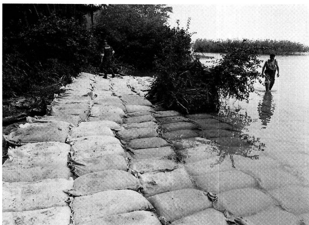
Fig. 1. Mise en place des sacs, en septembre 1992, pour protéger le site néolithique (Horgen) de Font FR-Sous l'Epenex. Photo Service Archéologique Cantonal FR.
