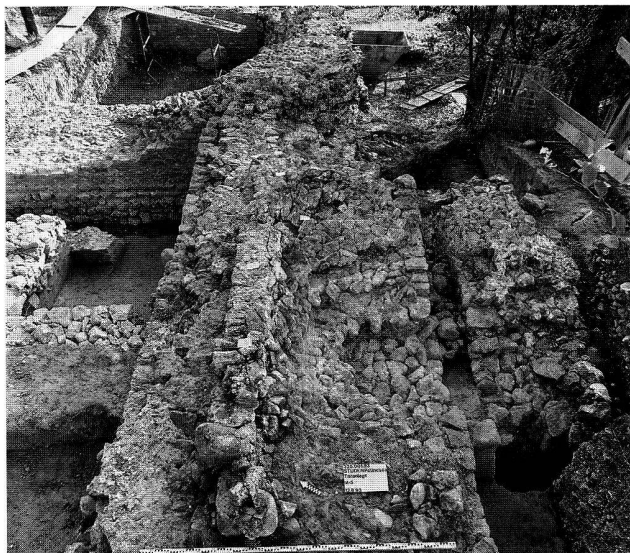
Abb. 30. Studen BE, Grabefeld/Petinesca. Nachgrabung 1993. In der Mitte und links im Bild erkennen wir die neu freigelegten, 3 m dicken Mauerzüge einer äusserst mächtigen Anlage; rechts die teilabgerissenen Reste eines älteren Gebäudes. Blick nach Nordosten.
