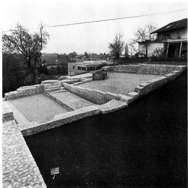
Abb. 24. Studen BE, Grabefeld Petinesca . Sanierung der römischen Anlage (Stand Herbst 1995).
