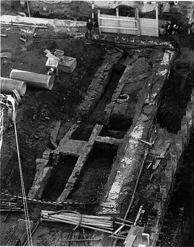
Fig. 34. Bellinzona TI, piazza del Sole. Panoramica dell'alto della situazione di scavo. Foto UCMS.
