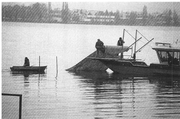
Abb. 20. Ermatingen-Westerfeld. Abrollen der Vliesmatte und Verlegen auf dem Seegrund, November 1998. Aufnahme AATG, T. Rey.
