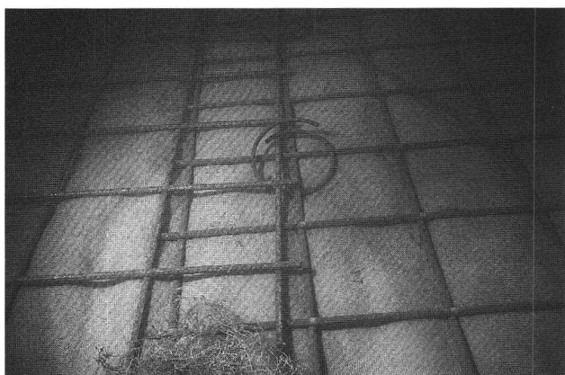
Abb. 24. Ermatingen-Westerfeld. Lage der Gitter auf der Vliesmatte mit den Verbindungsringen, November 1998. Aufnahme AATG, M. Schnyder.
