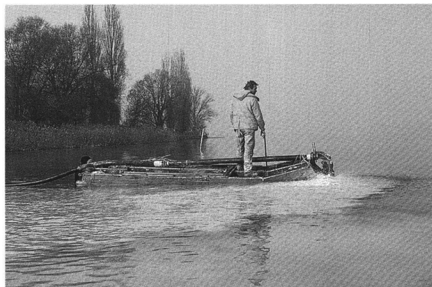
Abb. 26. Ermatingen-Westerfeld. Einbringen des Kieses über Druckleitung und Ponton, November 1998. Aufnahme AATG, T. Rey.
