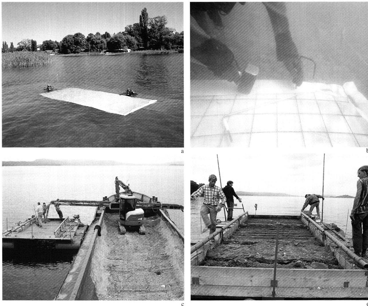
Abb. 2. Sutz-Lattrigen BE, Lattrigen Hauptstation-aussen. Schutzmassnahmen: a das mit Eisengitter verstärkte Geotextil wird gewässert und b auf dem Seegrund fixiert; c das Kies wird gleichmässig auf das Spezialponton verladen und d anschliessend über dem Geotextil eingebracht. Photos ADB.
