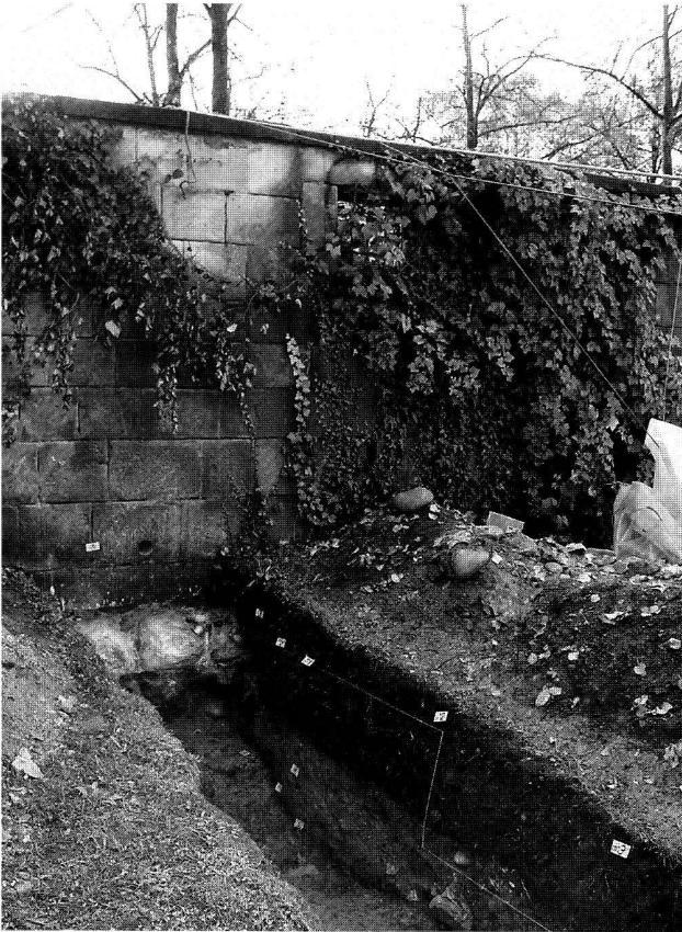
Abb. 11. Zürich ZH-Lindenhof. Nordabschnitt der Terrassen-Stützmauer, Blickrichtung Süden. Im Vordergrund ein Teil der Sondierung vom Sommer 2002. Die Stützmauer stammt in diesem Abschnitt aus dem 14. Jh. und wurde im 18./19. Jh. neu mit Sandstein verblendet. Darunter hell eine Steinreihe der ursprünglichen Mauerschale und darunter, schwach sichtbar, ein paar Steine der römischen Mauer. Im Graben der neuzeitliche Humus und darunter Reste von Gruben aus der Spätlatène-Zeit sowie die anstehende Moräne. Photo Stadtarchäologie Zürich.
