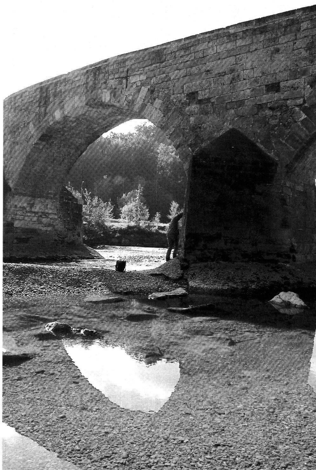
Abb. 34. Bischofszell TG, Thurbrücke. Beginn der Renovationsarbeiten an der im späteren 15. Jh. errichteten Steinbrücke. Photo Amt für Archäologie TG.
