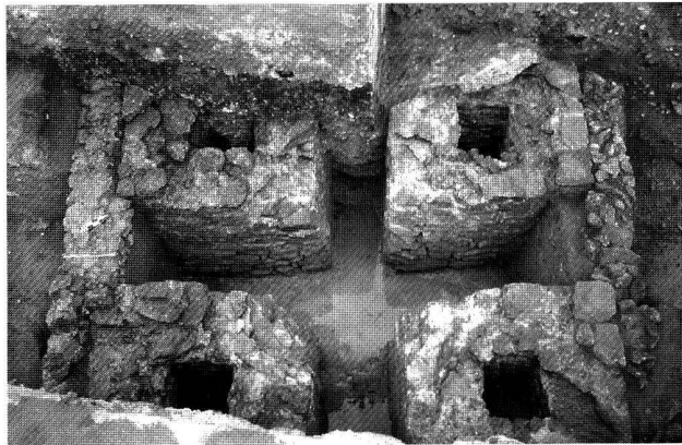
Fig. 18. Avenches VD, Temple de la Grange des Dîmes. Les piles maçonnées et leurs cavités découvertes à proximité du temple. De part et d'autre des piles, les vestiges de murets d'époque tardive. 1 er –3 e s. apr. J.-C. Photo Site et Musée romains d'Avenches.
