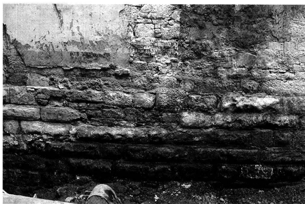
Abb. 31. Basel, Blumenrain 8. Blick auf die Fundamente des Salzturms. Foto ABBS.
