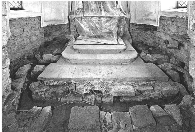
Abb. 45. Egg SZ, Etzelpasshöhe, Kapelle St. Meinrad. Blick nach Osten ins Chor mit teilweise freigelegten Belüftungskanälen unter dem Chorboden der 2. H. 18. Jh. Foto G. Sidler, Schwyz.
