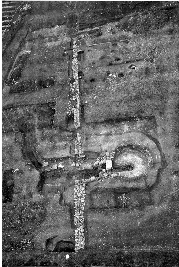
Abb. 29. Oensingen SO, Bienken. Die Umfassungsmauer schneidet den kleineren Kalkbrennofen (vorne am Bildrand) und steht mit der jüngeren Phase des grösseren Kalkbrennofens (hinten/Mitte) im Verband. Im Hintergrund sind die Pfostennegative des möglicherweise spätrömischen Holzgebäudes zu erkennen. Foto KA SO.
