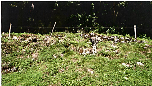
Abb. 9. Lungern OW-Alter Passweg, Abschnitt 2 (OW 2015.002). Blick vom Sewli-Dossen (Osten) auf die aus grossen Kalksteinen errichtete Trockenmauer, welche die talseitige Begrenzung des Passweges in der Flur Cholhüttliwald bildet. Blick nach Norden. Foto S. Chamberlain.
