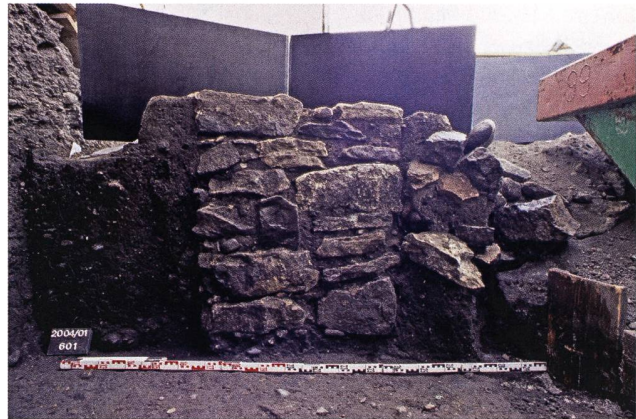
Abb. 16. Basel, Martinsgasse 6+8. Trocken gemauerter bzw. mit sehr wenig Mörtel aufgesetzter Mauerriegel HMA II fam 1 des eingetieften Gebäudes HMA II gru 1 von Osten. Vermutlich handelt es sich um die nachträgliche Unterfangung eines ursprünglich nicht unterkellerten Gebäudes. Foto ABBS, Ch. Stegmüller.
