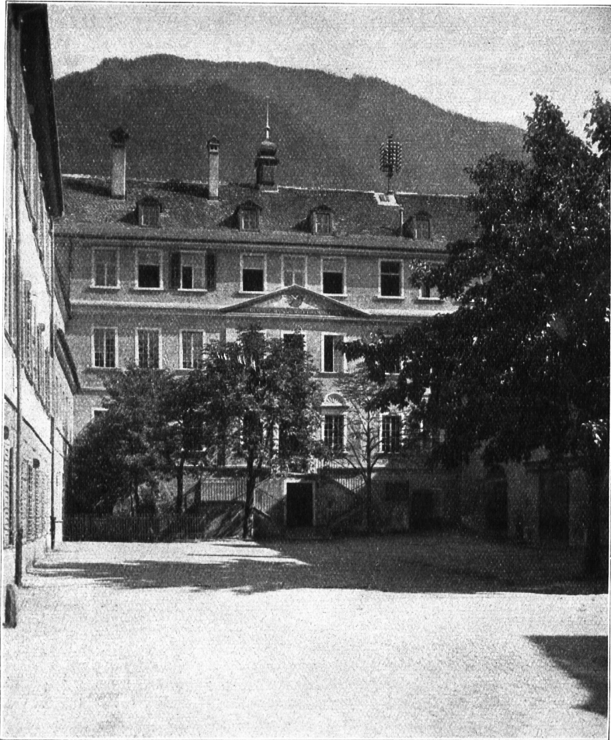
Alte Kantonsschule, jetzt Primarschulhaus
