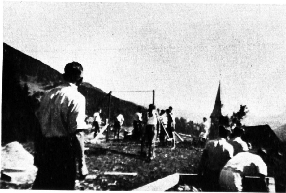
Vorn rechts wird die Sprunggrube gezimmert, hinten das Reck aufgerichtet. Alle Arbeiten sind in vollem Gange.
