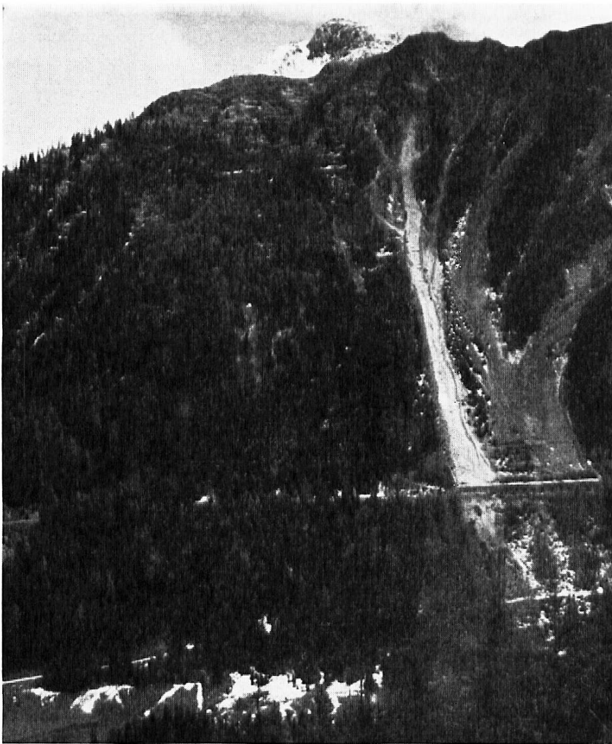
Lawinenverbauung zum Schutze der Rhätischen Bahn. Muot bei Bergün/ Bravuogn. Zustand 1907. Photo Rhäti- sche Bahn.
