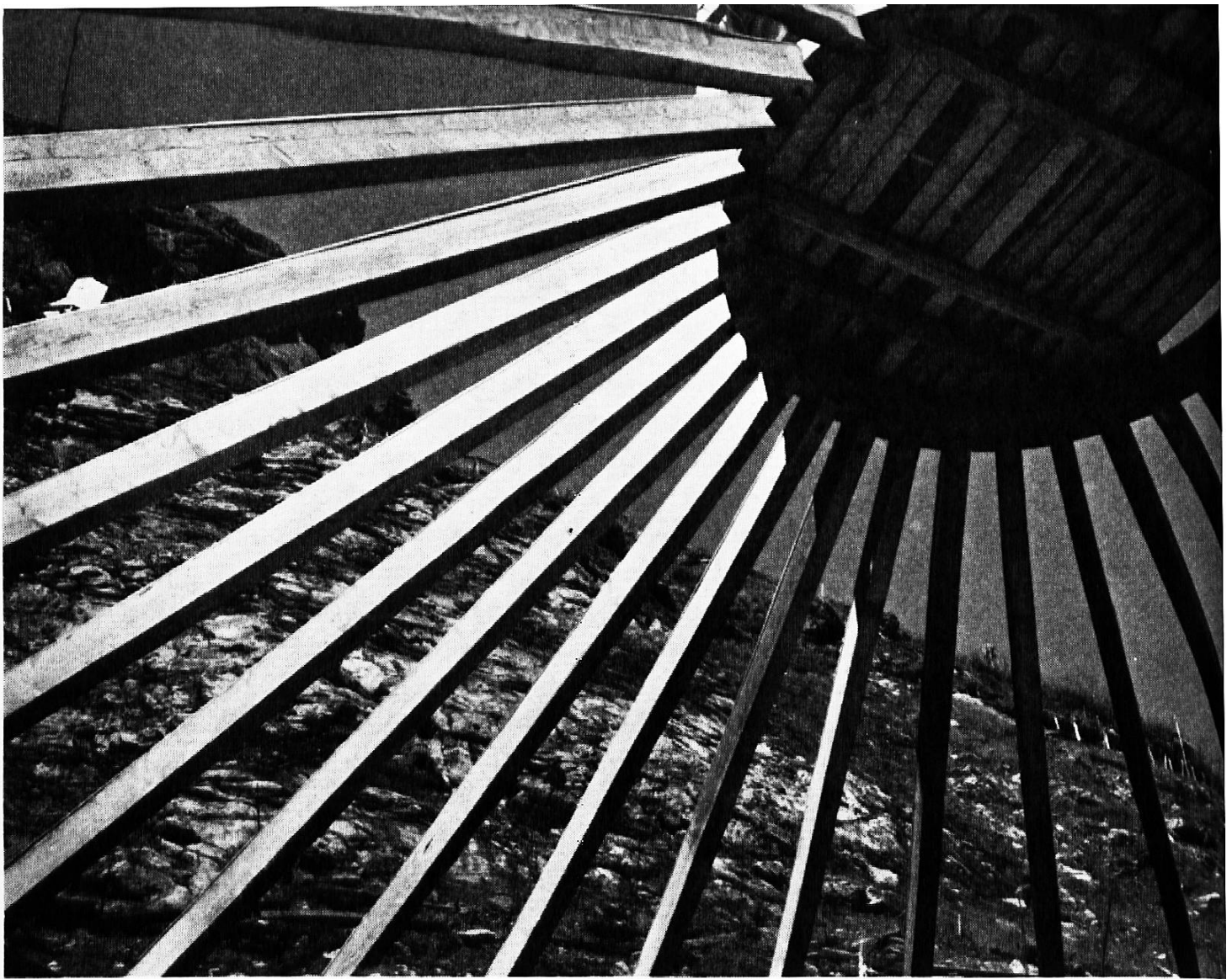
Kies- und Sandsilo-Abdeckung in Hetzerkonstruktion
