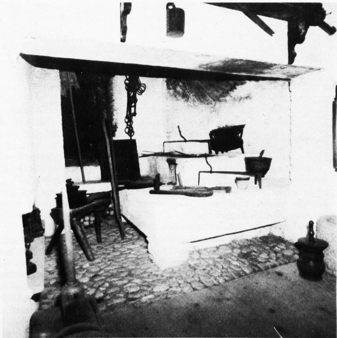
Beim Wiederaufbau nachgebaute Küche
