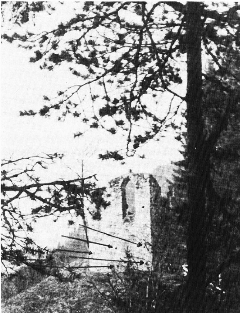
Abb. 13 Chorabschluss der Marienkirche von Osten her gesehen. Die Pfeile weisen auf die Gerüstlöcher hin.
