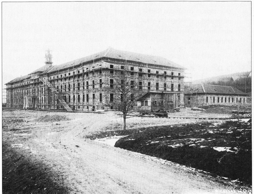
Der Bau der Klinik Waldhaus 1891/92 gilt als ein Markstein in der Geschichte der Psychiatrie im Kanton Graubünden.
