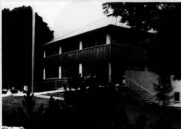
Das neue Fluryhaus
