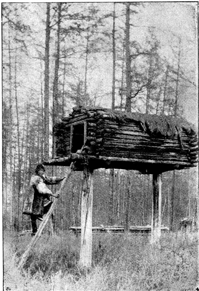
Ein jukagirischer Speicher auf Pfählen, um die Nahrung vor Bären zu schützen.
