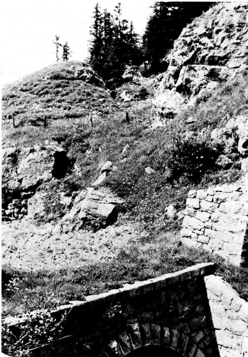
Südlicher Tunnelausgang W Bigelti. Darüber ein in Entwicklung begriffener Sackungsgraben.
