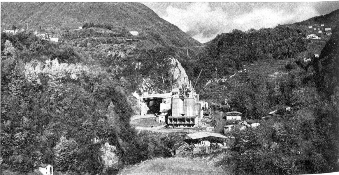
Abbildung 8 Blick von S gegen die Mündungsschlucht der Breggia. Links oben die Häuser von Ponte und Castel S. Pietro. Auf der Höhe der Zementfabrik ist links die Ponterinne und rechts diejenige des Nebenbaches von S. Martino zu sehen. In der Mitte des untern Bildrandes die künstlich planierte Scagliafläche mit einer nordwärts bis zur Zementfabrik verfolg- baren Moräne. Den Horizont bildet das asymmetrische Querprofil des südlichsten Teiles des Muggiotales.
