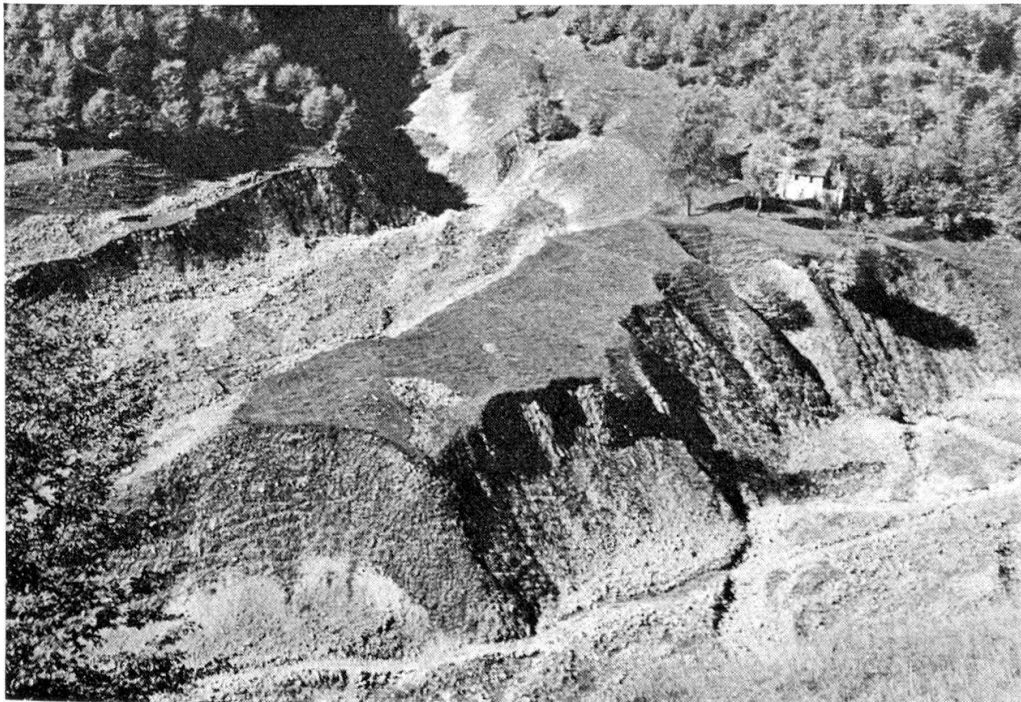
Abbildung 6 Der quer zur Aufnahmeichtung verlaufende Talboden der Breggia bei der Einmündung der Valle Squadrina. Der Bergsturz von Erbonne bewirkte eine vorübergehende Abriegelung des Tales und Aufschotterung. In die Schuttmassen hat sich die Breggia nach erfolgtem Durchbruch eingegraben.
