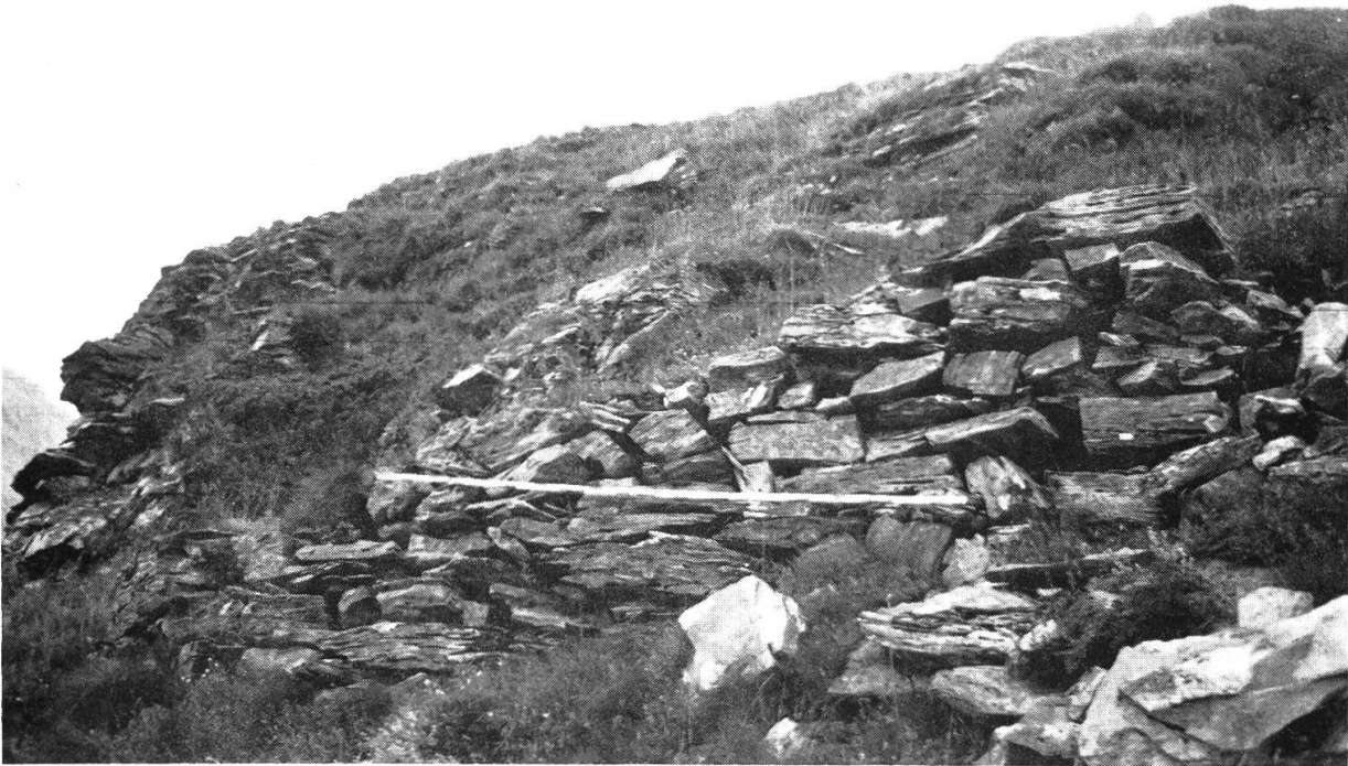
Fig. 3: Alte Gemmi – Südseite (AERNI 1971: Tafel 4, Alte Gemmi, Ziffer 12, A33). Letztes Mauerstück des gebauten oder gebahnten Weges über die Alte Gemmi. Vergleichsstrecke: 2 m. Standort: 615 875 / 138 710 / 2330 m; Bildmitte Az 5300 A ‰. LK 1267
