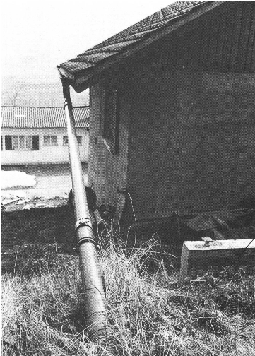
Abbildung 4: Die Nutzung von Regenwasser – eine alte jurassische Tradition – gestattet wesentliche Einsparungen von Trinkwasser.
