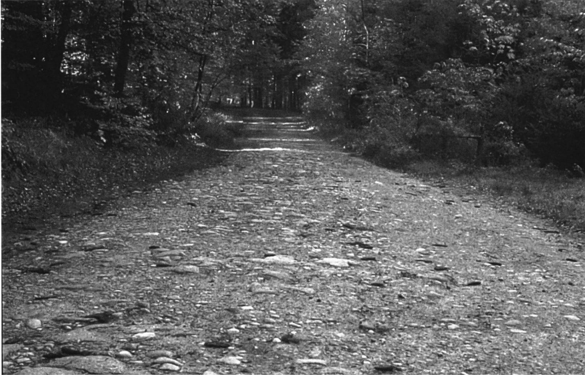
Abb. 1: Die angeblich «römische» Pflasterung im Sand bei Schönbühl-Urtenen entpuppte sich aufgrund der Arbeiten am IVS als Oberfläche der Chaussee aus dem 18. Jahrhundert. (Foto: Hp. Schneider)
