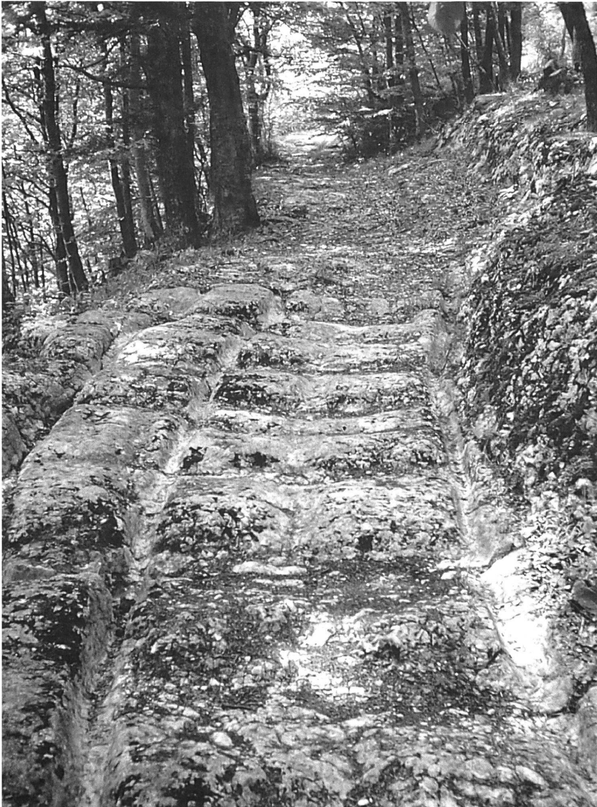
Abb. 4: Ansicht der Geleiseanlagen beim Profil C (vgl. Abb. 2b). Deutlich ausgeprägt sind die Zwillingsgeleise der jüngsten Generation mit der dazwischenliegenden, mit Stufen versehenen Gehfläche. Innerhalb dieser Gehfläche ist das fast vollständig abgetragene bergseitige Zwillingsgeleise der Vorgängergeneration sichtbar; deren talseitiges Zwillingsgeleise ist am linken Bildrand gut zu erkennen. (Foto: G. Schneider)
