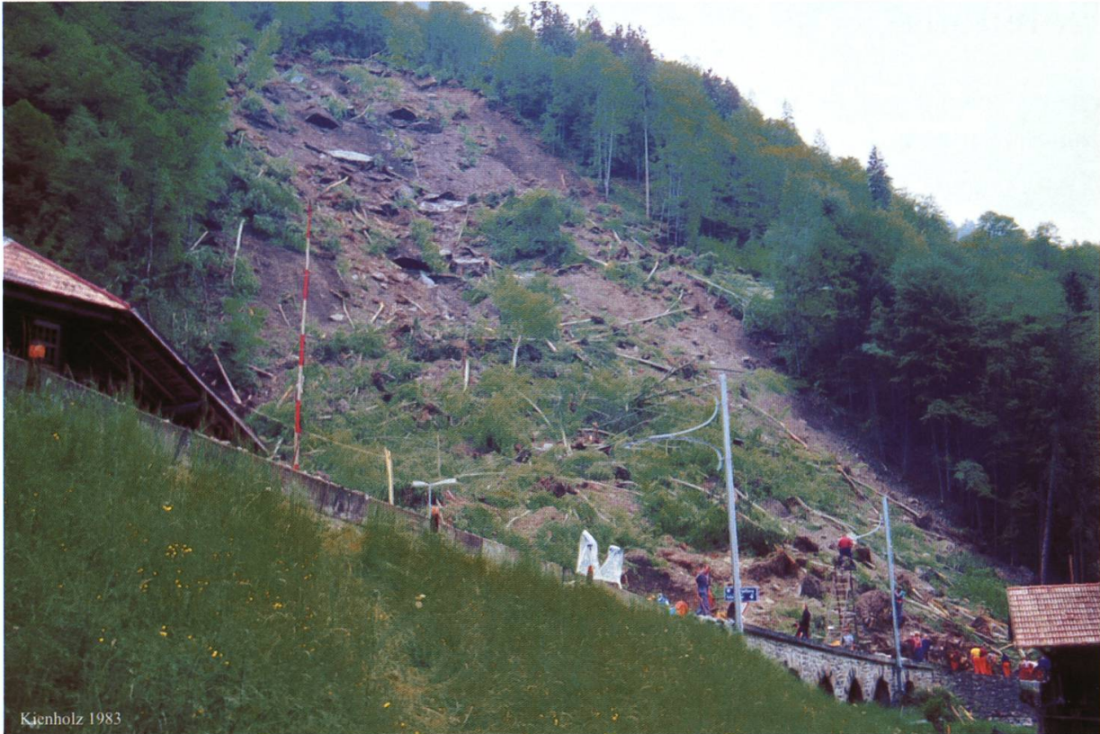
Abbildung 1: Rutschhang (Tripfi / Lauterbrunnen). Ein natürlicher Vorgang wird zur Gefahr für Menschen und Sachwerte. Mit der Bedrohung von Infrastrukturen sind oft auch indirekte wirtschaftliche Schäden (z. B. Sperrung von Verkehrswegen) verbunden. (Foto: H. Kienholz, 1983)
