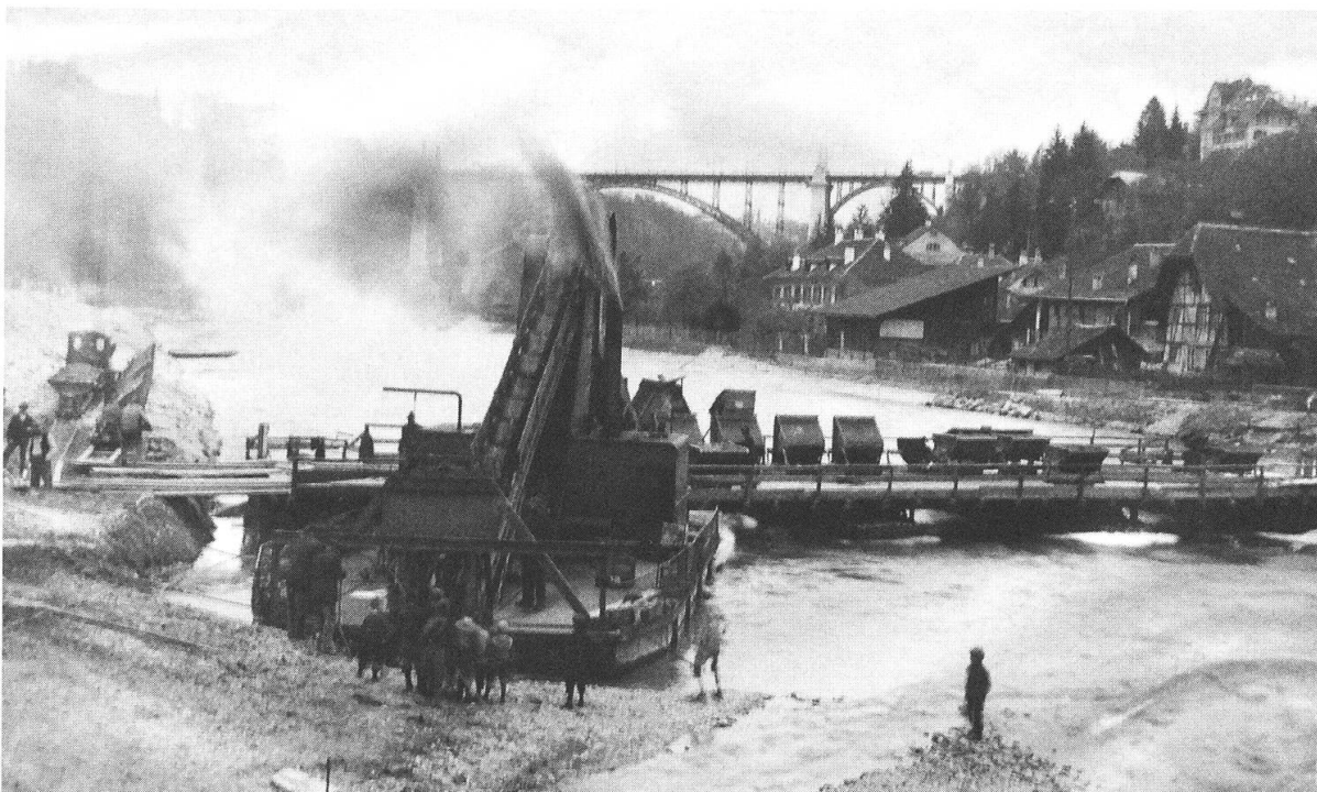
Abb. 16: Dampfbagger 1913 im Einsatz zur Abtiefung der Aaresohle im Altenberg, im Hintergrund die Kornhausbrücke
