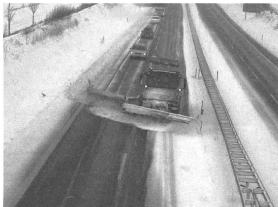
Abbildung 13: Front- und Seitenschneepflug im Einsatz auf der Autobahn. (Bild: Zaugg AG)
