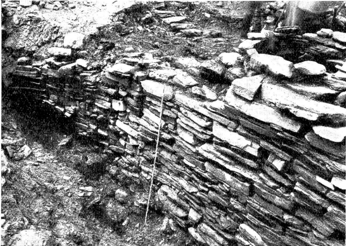
Bild 9: Crestaulta, große Stützmauer
