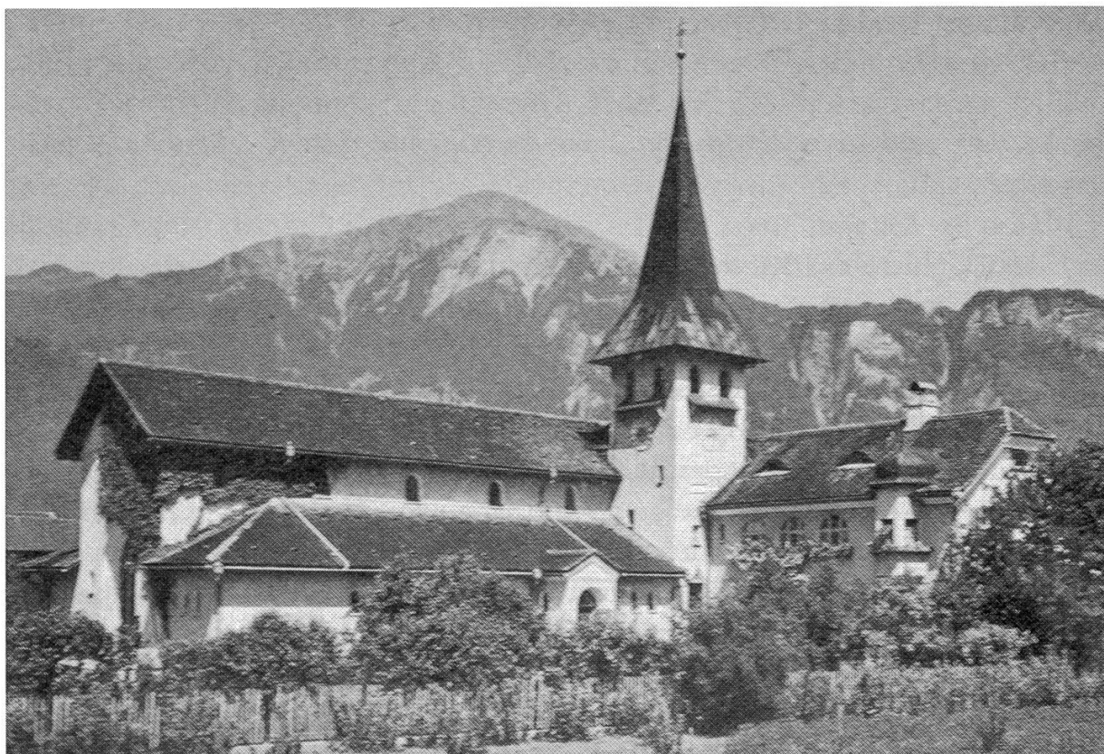
Abb. 1 Bedingt durch den aufkommenden Tourismus und den Eisenbahnbau entstanden in Graubünden zwischen 1860–1930 zahlreiche Kirchen. Die katholische Kirche Landquart, 1908 von den Architekten Schäfer & Risch, Chur, erbaut, entsprach dem Typus eines kleineren Diasporagotteshauses.
