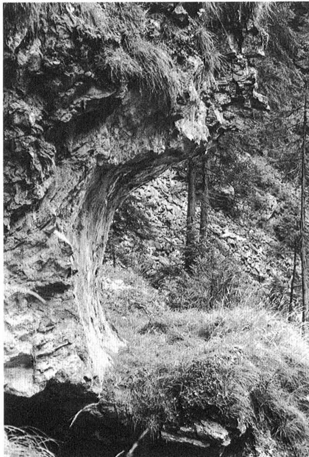
Abb. 7 Seitenansicht der Halbgalerie in der Viamala-Schlucht (Photo A. Planta)
